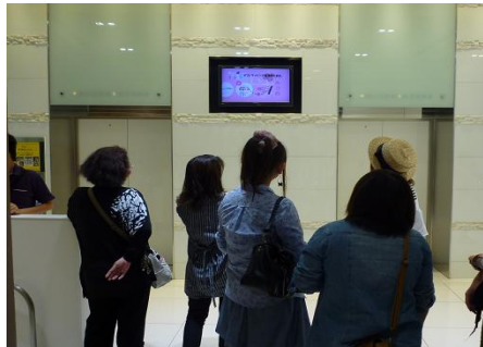
B1F、1Fエレベーター前設置VISION (32 inch)
